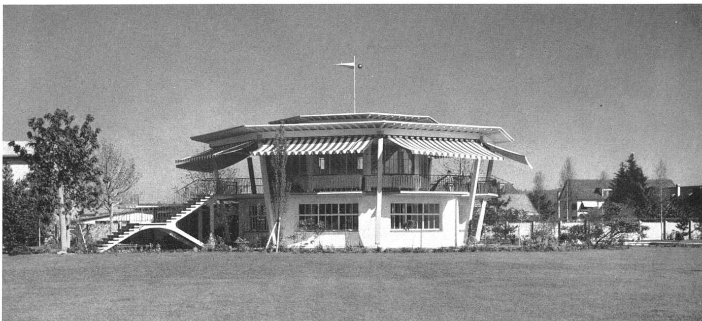
Terrassenrestaurant. Im Erdgeschoß Küche mit Nebenräumen und Kiosk | Restaurant; au rez-de-chaussée, la cuisine et le buffet | Terrace restaurant; on ground-floor level, kitchen with service rooms and kiosk Photo: M. Wolgensinger SWB, Zürich
