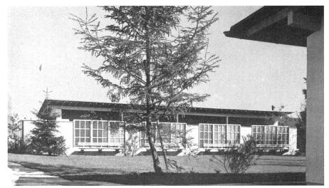
Garderoben pavillon. Sichtmauerwerk in Kalksandstein mit Betonrahmenfenstern | Pavillon des vestiaires | Cloakroom pavilion. Masonry in cement blocks, windows with concrete frames
