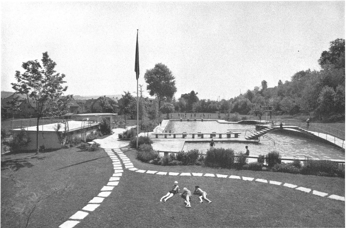
Bassin-Ansicht von Westen, im Vordergrund Nichtschwimmerbecken, links Filteranlage mit Kiosk | Le bassin vu de l'ouest; à gauche bâtiment de filtrage et le buffet | The pool from west, in foreground the pool for non-swimmers, at left the filtering plant with kiosk Photo: M. Wolgensinger SWB, Zürich
