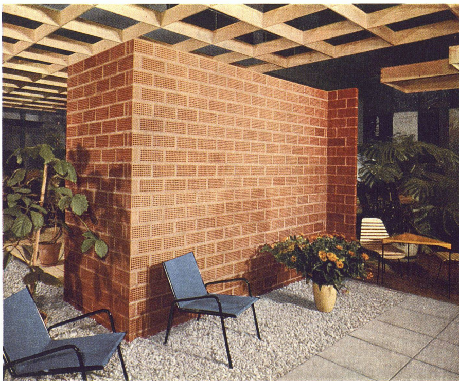
Sichtmauerwerk mit gestellten Wabensteinen 25|12|6 cm, aus dem Tonwerk Döttingen, der A.G. Hunziker & Cie.
