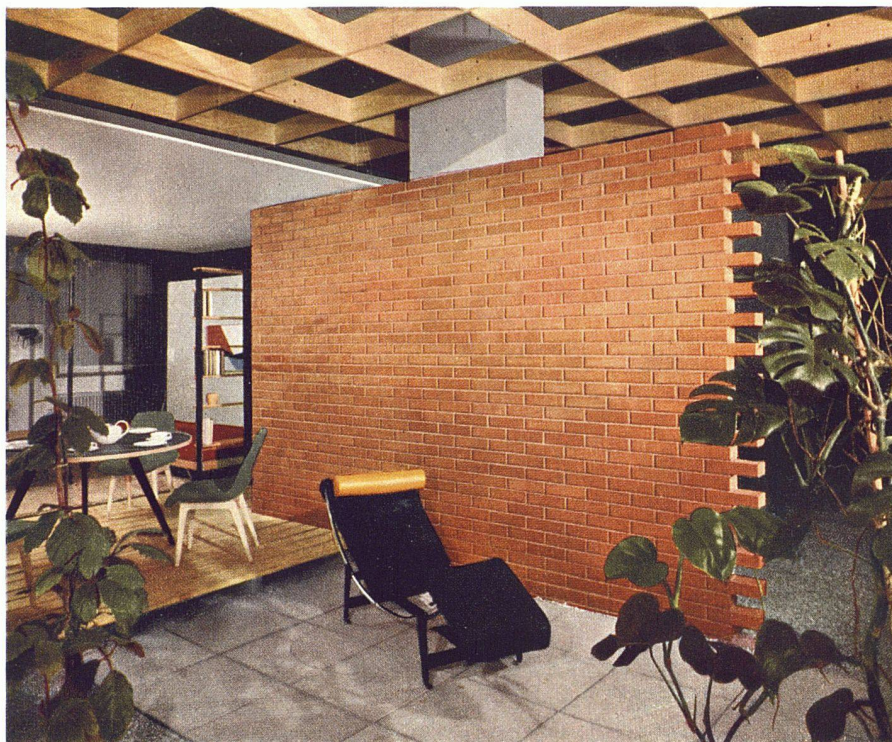
Sichtmauerwerk mit Normal-Backsteinen 25|12|6 cm, aus dem Tonwerk Döttingen, der A.G. Hunziker & Cie.
