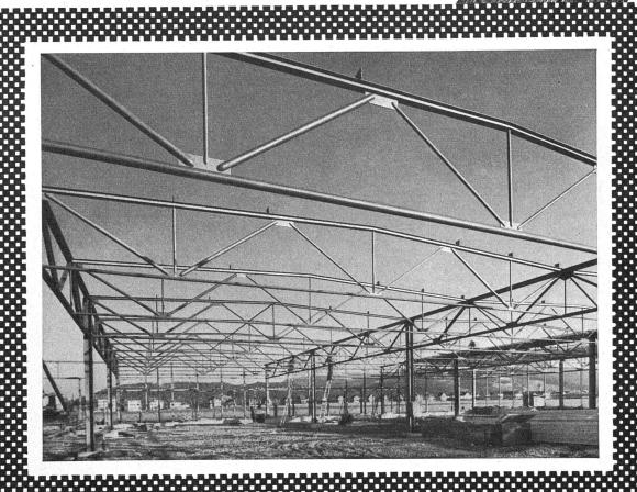
GESCHWEISSTER INDUSTRIE-BAU, TEILWEISE IN NEUARTI-GER ROHRKONSTRUKTION FÜR EINDECKUNG MIT HOLZSPARREN, SCHALUNG UND KIESKLEBEDACH. FELDERTEILUNG: 12,00 × 14,00 m GRUNDFLÄCHE: 56,00 × 48,00 m AUSFÜHRUNG 1949
