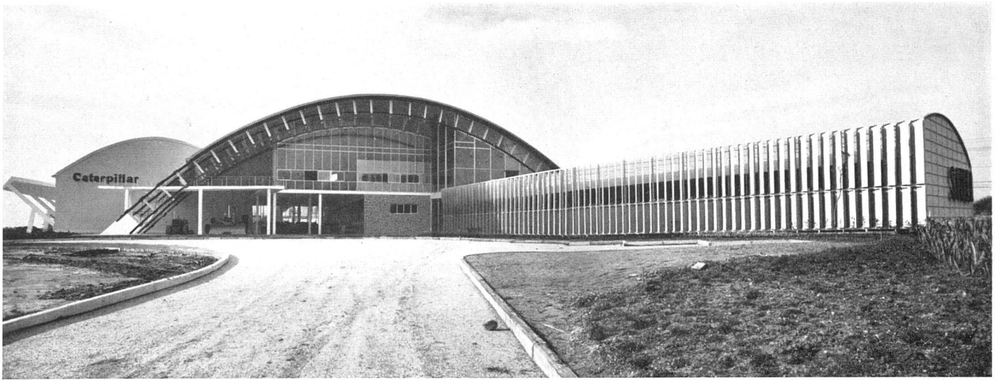
Gesamtansicht. Rechts Bürogebäude, Mitte Besucherteil und Ausstellung, links Werkhalle. Bogen, 45 m Spannweite, in Holz mit Eternitabdeckung, vor den Büros Welleternit-Sonnenschutz | Vue générale. A droite les bureaux, au centre la halle d'exposition et la partie réservée aux visiteurs, à gauche la halle des machines. Arc en bois de 45 m de portée avec recouvrement en éternit. Devant les bureaux brise-soleil en éternit | General view, right offices, middle visitors' section and exhibitions, left workroom. Arch in wood, 45 m span, covered with eternit, facing offices wave-eternit sun breaker Interphoto News Pictures, Overseas-Press
