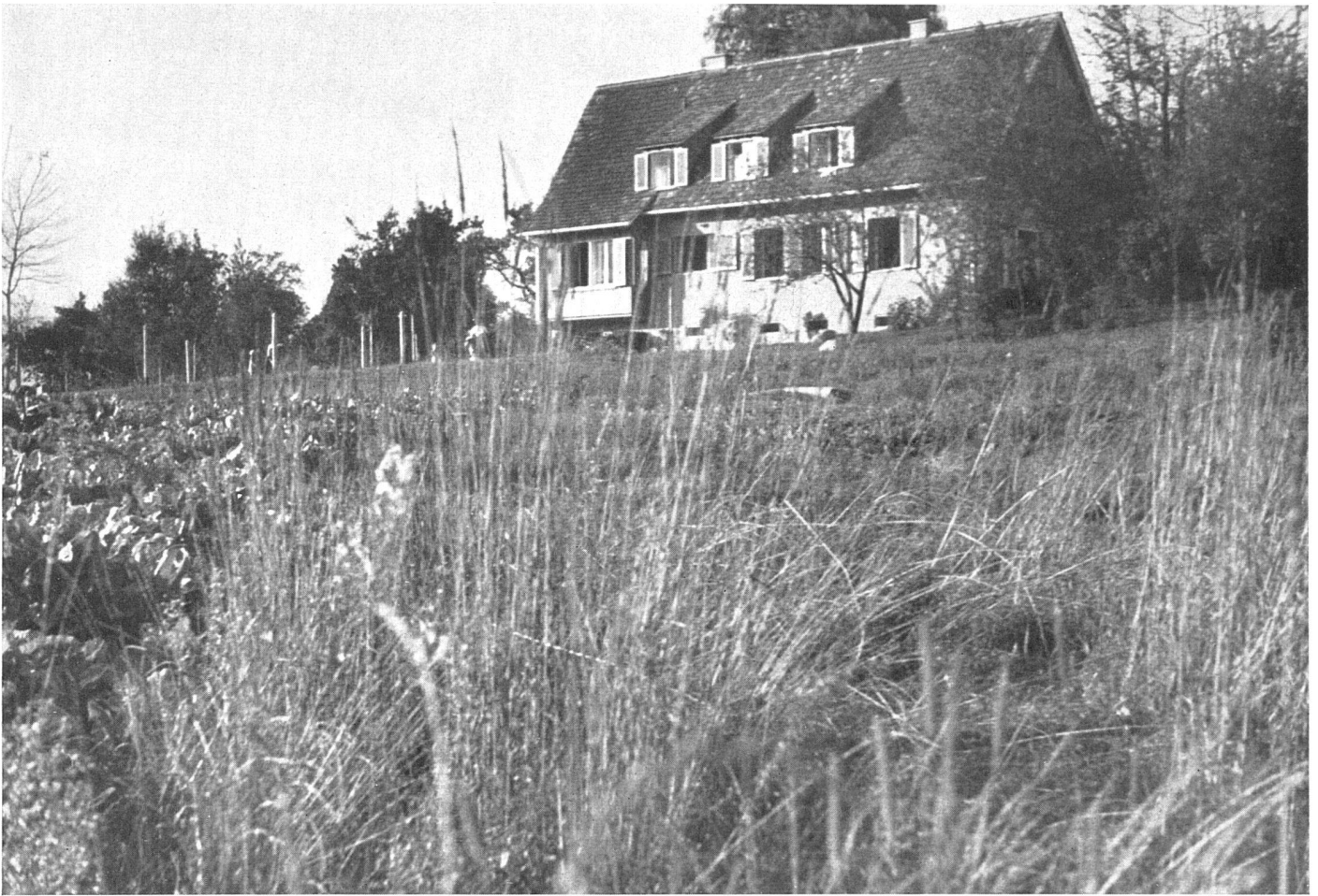
Blick aus dem «Moos» gegen die Südseite des Hauses | Façade sud | South elevation
