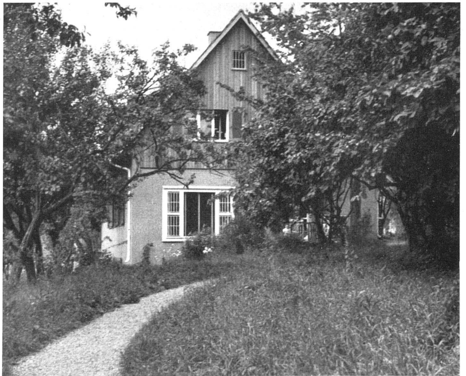
Zugang zum Haus mit Ostgiebel / Chemin d'accès et pignon est / Way to the house from east
