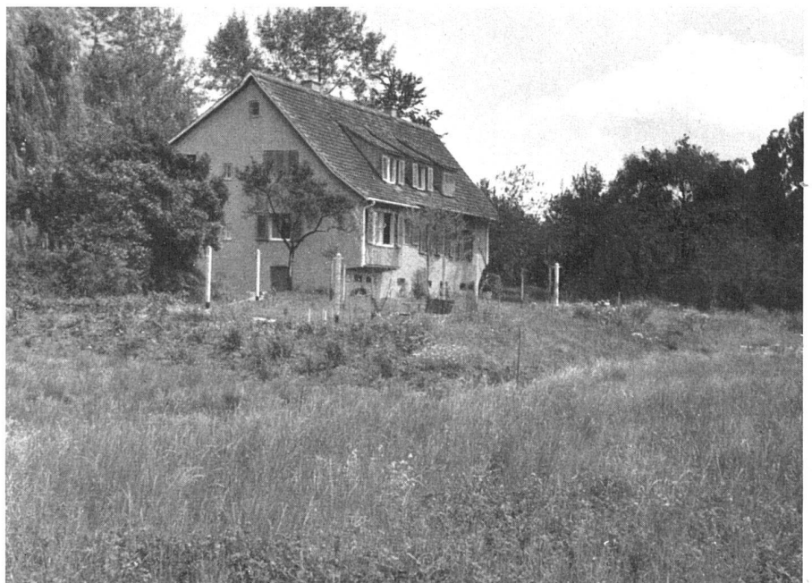
Blick aus dem «Moos» gegen die West- seite des Hauses / La façade ouest vue du «Moos» / West elevation
