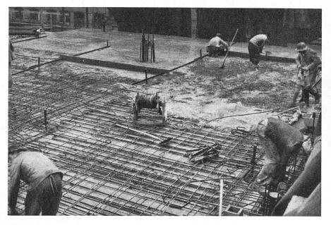
3700 m³ PLASTOCRETE-Beton für die armierte Betonkonstruktion, bestehend aus Fassadenund Stützpfeilern sowie Decken
