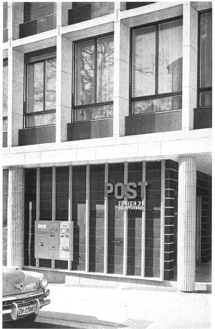
Fassadendetail. Pfeiler mit Kunststeinverkleidung, Brüstung Keramik grün | Détail de façade. Pilier à revêtement simili-pierre, contre-cœur en céramique verte cannellée | Detail of façade. Pillars with artificial stone facing, breastwall in green ceramic. Photo: M. Wolgensinger SWB, Zürich
