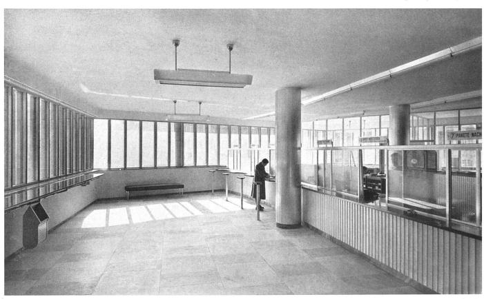
Kiosk. Betonsprossen mit schwarzen Keramikfüllungen, rot ausgefugt. Säule mit hellen Keramikplatten verkleidet | Kiosque. Béton et panneaux de céramique, joints rouges. Colonne recouverte de plaques de céramique claire | Kiosk. Concrete strips with black ceramic insertions bordered in red. Pillars faced with light ceramic flags
