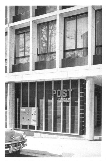
$Fassaden detail. \ Pfeiler \ mit \ Kunststeinverkleidung, \ Brüstung \ Keramik \ grün \ | \ Détail \ de façade. \ Pilier \ à revêtement simili-pierre, contre-cœur en céramique verte cannelée \ | \ Detail \ of façade. \ Pillars \ with \ artificial \ stone facing, breastwall in green ceramic. \ Photo: M. Wolgensinger SWB, Zürich$
