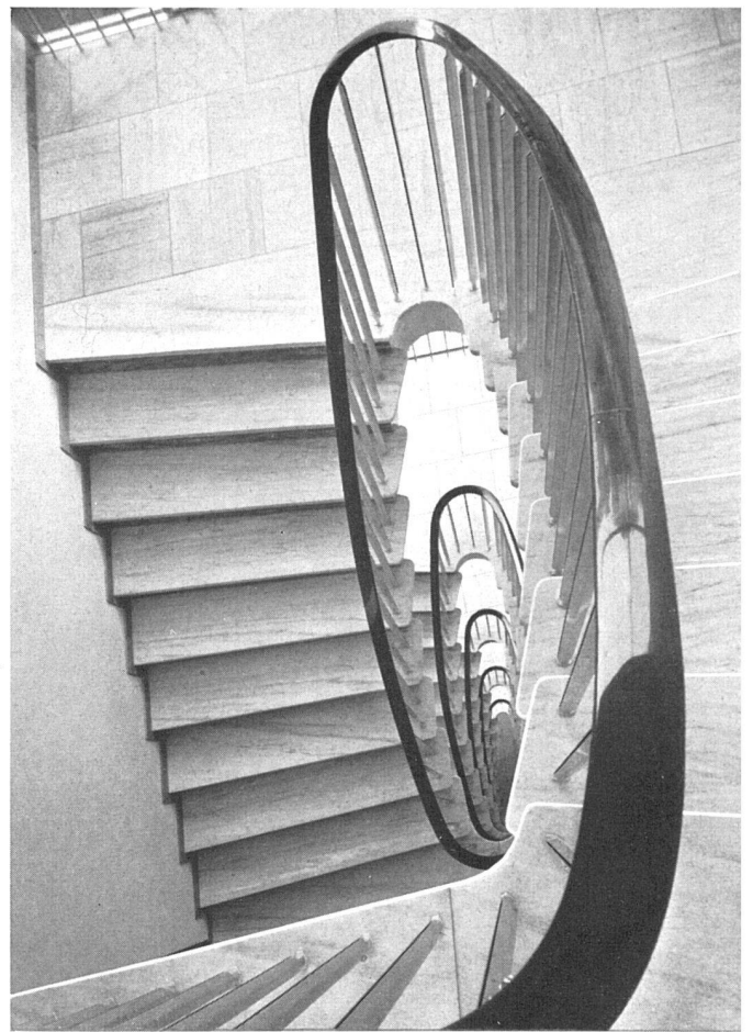
Treppenhaus. Geländer Anticorodal, Bodenplatten Schweizer Marmor | Vue du haut de la cage d'escalier. Main-courante en anticorodal, sol en marbre suisse | Staircase. Anticorodal handrail. Swiss marble flags
