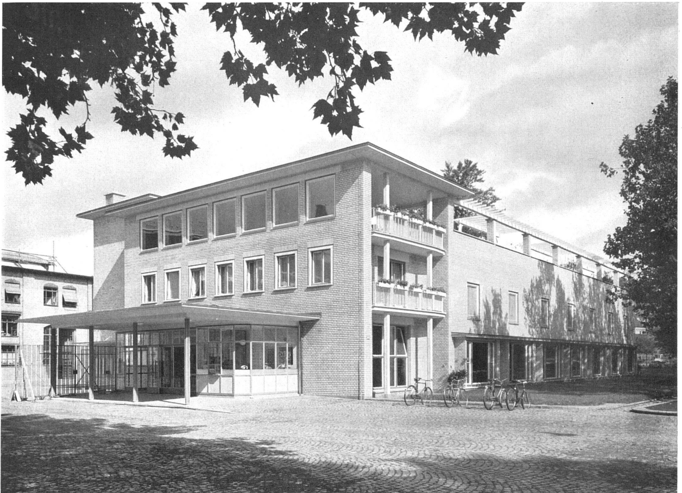
Eingangseite, links Fabrikeingang | Cantine de la Fabrique de Machines Escher Wyß à Zurich. Façade d'entrée. A gauche l'entrée de la fabrique | Welfare centre of the Escher Wyß Machines Factory, Zürich. Entrance, left factory entrance Photo: M. Wolgensinger SWB, Zürich
