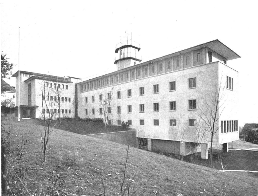
Ansicht von Nordwest | Vue prise du nord-ouest | North-west elevation
