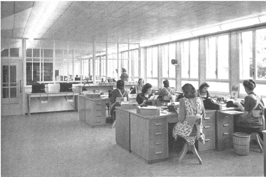
Büro. Decken mit Akustik-Platten verkleidet | Bureau. Plafond recouvert de plaques acoustiques | Office. Ceilings faced with acoustic-sheeting
