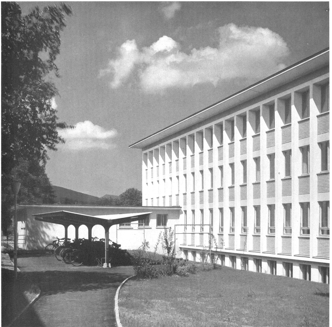
Lagertrakt von Norden. Betonskelett mit Kalksandsteinbrüstungen | Le dépôt vu du nord. Squelette en béton armé et parapet en briques calcaires | Store tract from the north. Concrete skeleton with chalk sandstone sills Photo: Rubin, Olten
