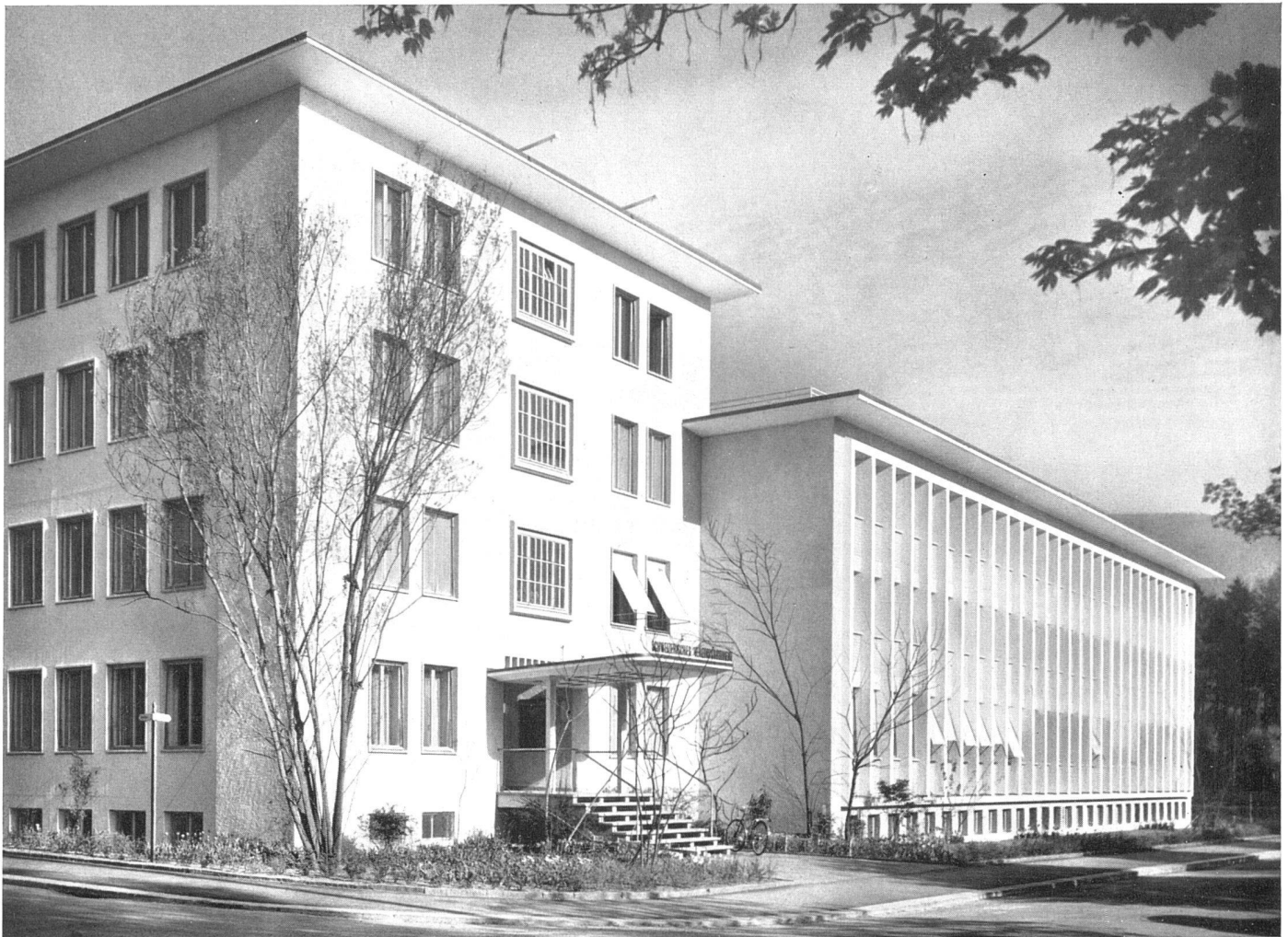
Ansicht von Süden. Links Haupttrakt (Büros), rechts Lagertrakt | Façade sud. A gauche l'aile principale (bureaux), à droite le dépôt | South elevation. Left main tract, right stock tract
