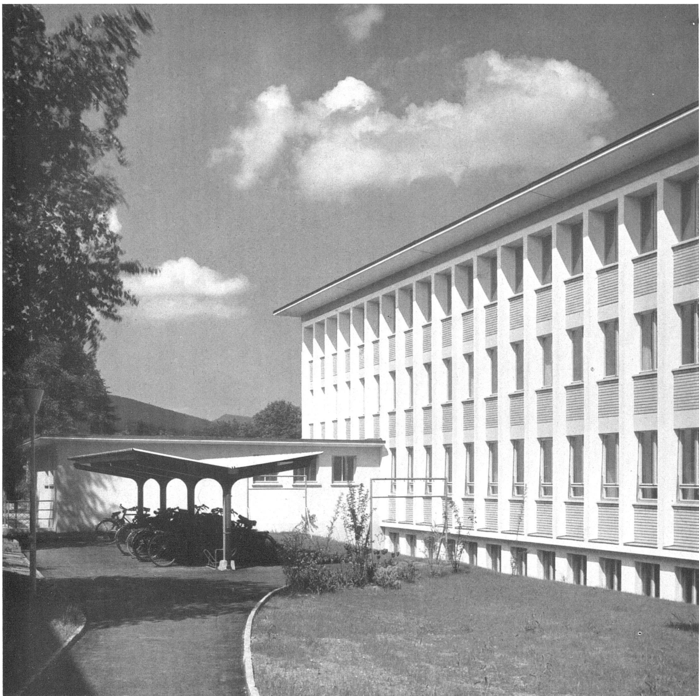
Lagertrakt von Norden. Betonskelett mit Kalksandsteinbrüstungen / Le dépôt vu du nord. Squelette en béton armé et parapet en briques calcaires / Store tract from the north. Concrete skeleton with chalk sandstone sills
