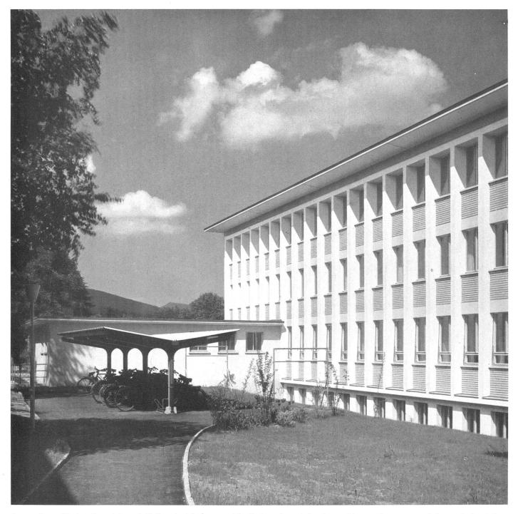
$Lagertrakt \ von \ Norden. \ Betonskelett \ mit \ Kalksandsteinbr\"{u}stungen \ | \ Le \ d\acute{e}p\^{o}t \ vu \ du \ nord. \ Squelette \ en \ b\acute{e}ton \ arm\'{e} \ et \ parapet \ en \ briques \ calcaires \ | \ Store \ tract \ from \ the \ north. \ Concrete \ skeleton \ with \ chalk \ sandstone \ sills$
