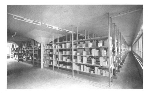
Lagerraum, Eisenbeton mit Pilzdekken. Fluoreszenzröhren-Beleuchtung | Intérieur du dépôt. Dalle de béton à champignon. Eclairage par tubes fluorescents | Store room reinforced concrete with mushroom ceiling. Fluorescent tube lighting
