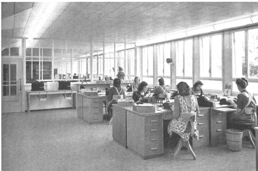
Büro. Decken mit Akustik-Platten verkleidet | Bureau. Plafond recouvert de plaques acoustiques | Office. Ceilings faced with acoustic-sheeting
