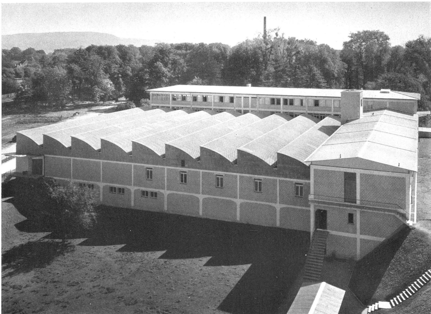
Ansicht der Gesamtanlage aus Westen. Sheds mit gewölbtem Wellteernit abgedeckt, übrige Dächer und Spenglerarbeiten in Alumanblech. Im Vordergrund Terrain für spätere Erweiterung | Vue générale prise de l'ouest. Sheds recouverts d'éternite ondulé et cintré. Les autres toits, comme tous les ouvrages de la ferblanterie, sont en tôle d'Aluman. Au premier plan, le terrain réservé aux agrandissements futurs | View of the general lay-out. Saw-tooth roof covered with vaulted undulating Eternit. Remaining roofs and plumbing in alumantín. In foreground space for later extension Photo: R. Spreng SWB, Basel
