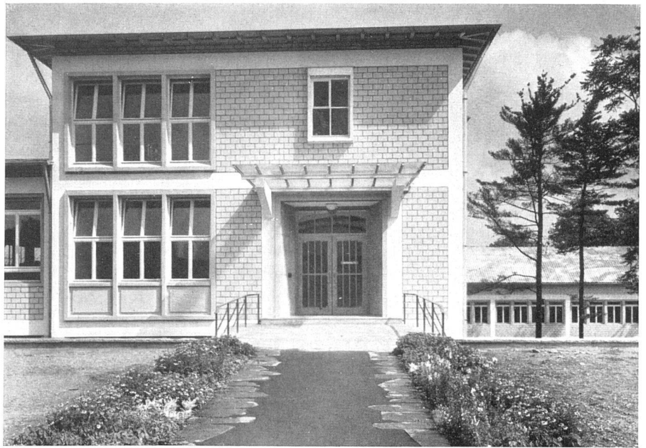
Besucherzugang St. Jakobsstraße. Eisenbetonskelett, mit Kalksandstein ausgefacht | L'entrée de la St. Jakobsstraße, réservée aux visiteurs. Squelette en béton avec remplissage en brique calcaire | Visitor's entrance. Reinforced concrete skeleton with chalk sandstone casing
