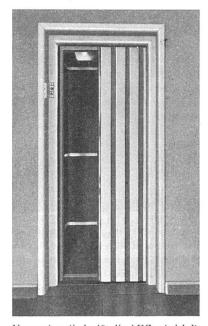
Neue automatische für die AKZ entwickelle Lift-Schiebetüre «Portaflex». Schweizerische Wagons- und Aufzügefabrik AG. Schlieren-Zürich
