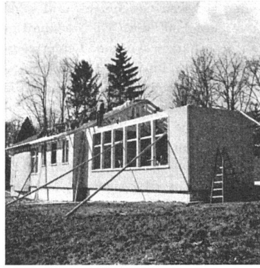
Der Pavillon im Bau (Montagebauweise)
