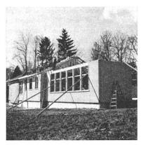
Der Pavillon im Bau (Montagebauweise)
