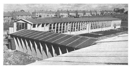
Vorderansicht. Die abstehenden Lamellen sind zur Windversteifung notwendig. The Bristol Aeroplane (Housing) Company Ltd.
