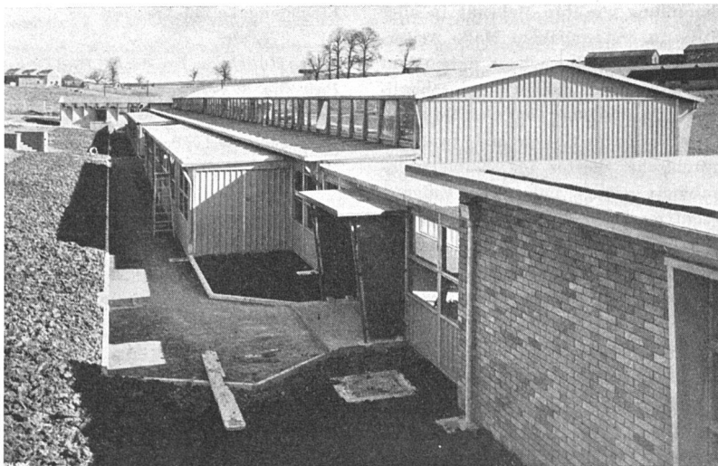
Schule in Bristol aus vorfabrizierten Aluminium-Elementen. Rückansicht
