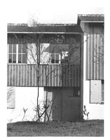
$Haus\ E:\ Eingang.\ Schalung\ lasiert\ und\ lackiert,\ Deckleisten$  \\ \\ \"{Ol-}\ und\ Lackanstrich\ /\ Type\ E:\ entrée\ /\ Entrance\ type\ E
