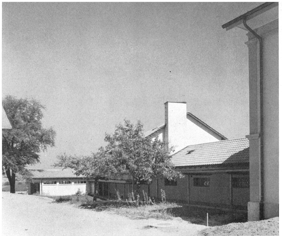
Ansicht des Neubaus von Westen, im Hintergrund der Reinigungspavillon / Le nouveau bâtiment vu de l'ouest, à l'arrière-plan l'annexe-vestiaire / West view of the new building: the annex in the background contains the changing and scrubbing room
