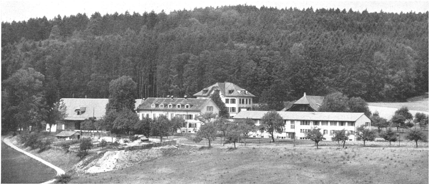
Gesamtansicht von Süden, rechts Neubau | Vue d'ensemble (sud), à droite le nouveau bâtiment | General view from the south, at right the new building
