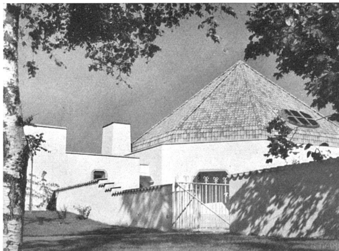
Teilansicht | Partie de la façade | West elevation
