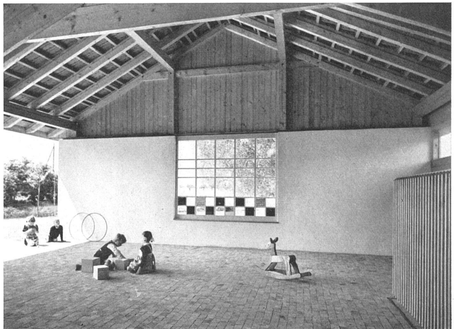
Spielhalle; Holzplästerung als Bodenbelag ist weich, warm und schalldämpfend / Préau; le pavé de bois du plancher est souple, chaud et anti-sonore / Covered play-hall; the wood paved floor is soft, warm and noise-absorbing
