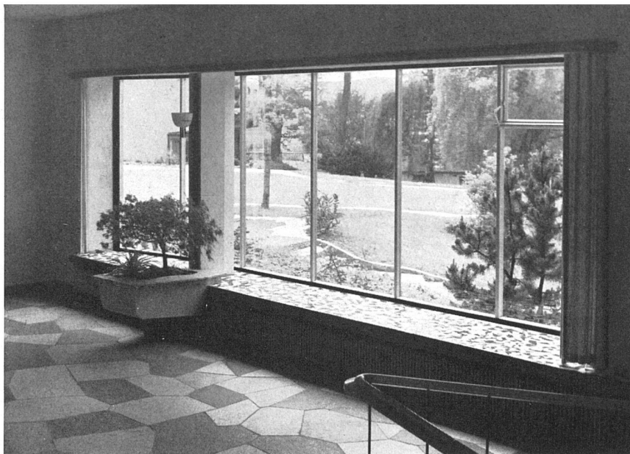
Eingangshalle, Bodenbelag aus Granit, Quarzit und Serpentin, Fenstersims auf Sitzhöhe mit farbigem Mosaikbelag / Hall d'entrée; Sol en dalles de granit, quartzite et serpentine; les bords des fenêtres, en mosaïque, servent de bancs / Entrance-hall; flooring of granite, quartzite and serpentine; the children can sit on the coloured mosaic window-sill Sämtliche Photos O. Pfeiffer SWB, Luzern
