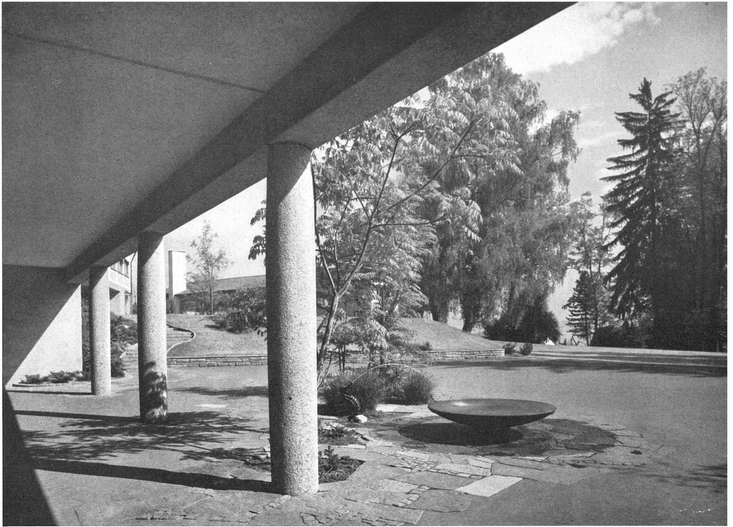
Spielhalle und Pausenplatz mit Brunnenschale und Wasserspeier (Seepferdchen von Paul Kyburz, Luzern). Säulen aus Osogna-Granit, Bodenbelag aus Quarzitplatten, bunter Kleinpflasterung und hellbraunem Asphalt | Préau ouvert et terrain de récréation avec vasque alimentée par un hippocampe. Colonnes de granit, sol en dalles de quartzite, mosaïque polychrome et asphalte | Covered play-hall and recreation ground with fountain and jet in form of a sea-horse. Columns of granite, flooring of quartzite slabs, coloured mosaic and asphalt
