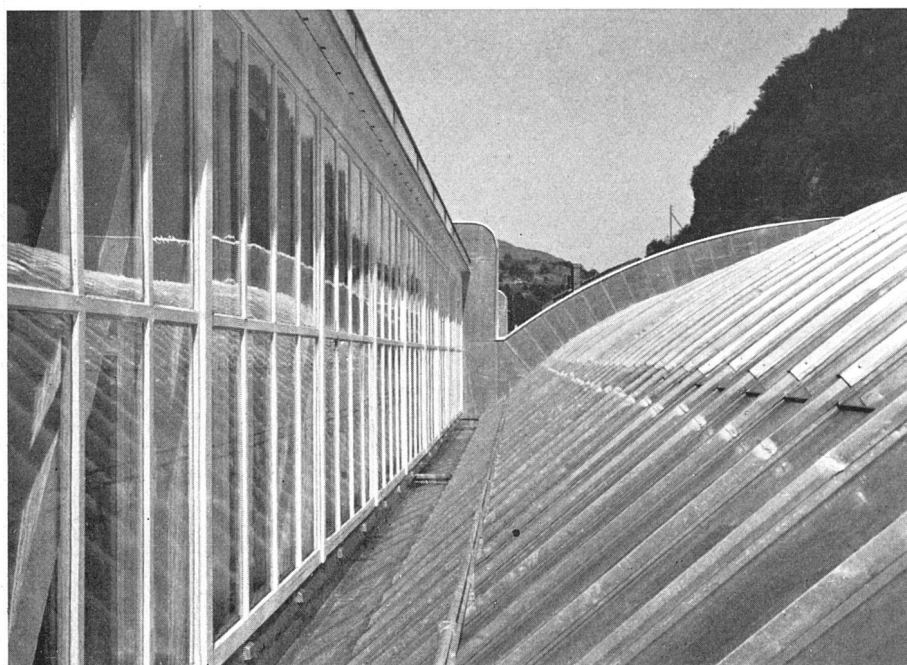
Detail der Sheds mit Regenrinne / Détail des «sheds», avec gouttière / Detail of the roof with rain-pipe
