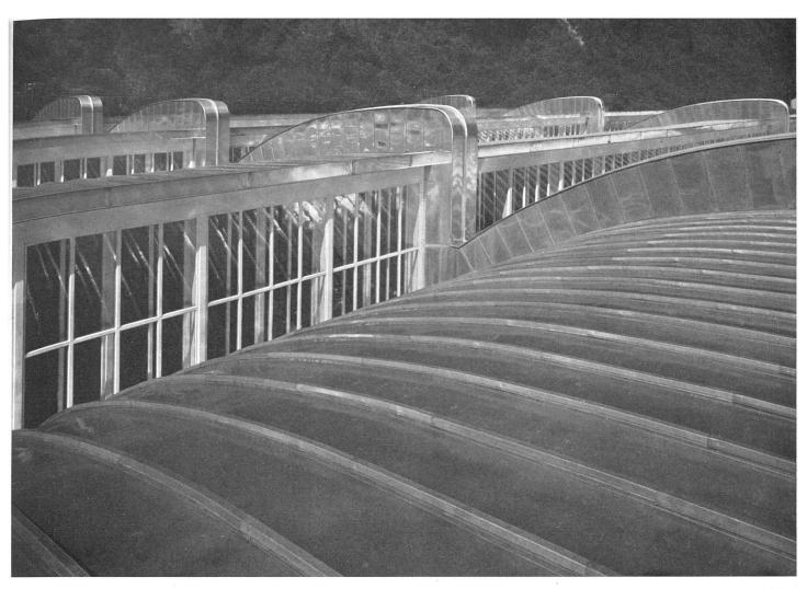
Blick über die mit Aluminiumblech eingedeckten Sheds | Les «sheds» couverts d'aluminium | Aluminium-covered saw-tooth roof
