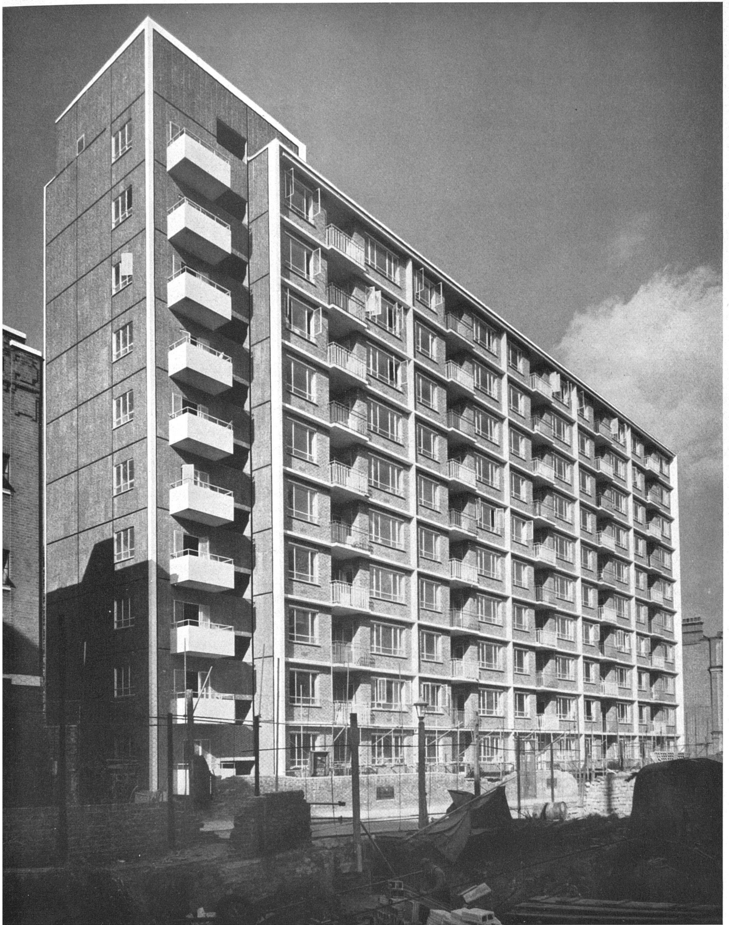
Südsicht, Dombey Street, Holborn, links Treppenhaus mit Waschküchen, ganz oben Wasserreservoir / Façade sud; à gauche, la cage d'escalier et, chaque étage, les buanderies / South elevation, at left the staircase and on each floor the laundries Photo: Leonard G. Taylor A. I. B. P., London
