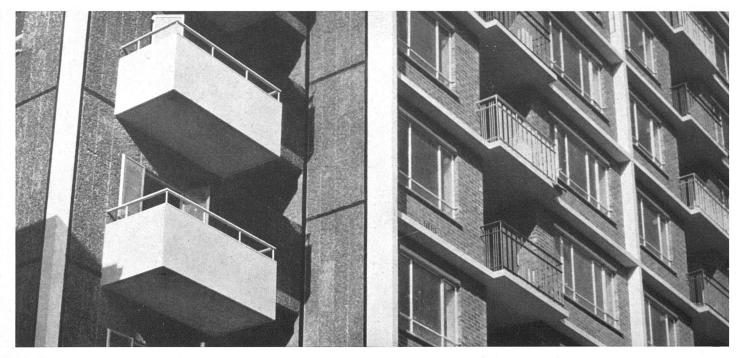
Fassadenausschnitt. Fassadenverkleidung links aus vorfabrizierten Betonplatten mit eingelegtem Ziegelschrot, Betonflächen weiß | Partie de la faças sud. Les façades de gauche sont revêtues de dalles en béton préfabriquées et dont la surface est composée de débris de brique | Part of south elevatio The flank façades at left are clad with prefabricated concrete slabs with a surface composed of broken brick
