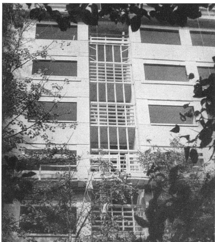
Groupe L, vitrage d'escalier en éléments préfabriqués / Wohnblock L, Treppenhausfenster aus vorfabrizierten Betonelementen / Block L, staircase window made of prefabricated units
