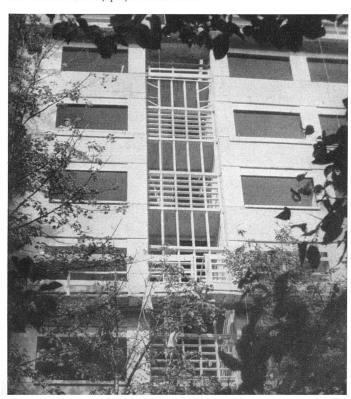
Marches et rampe d'escalier en éléments préfabriqués | Treppenhaus, Tritte und Geländer aus vorfabrizierten Betonelementen | Stair treads and railing made of prefabricated units
