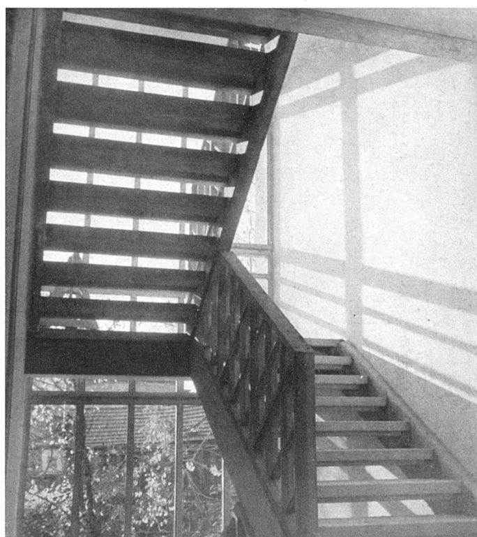
Marches et rampe d'escalier en éléments préfabriqués / Treppenhaus, Tritte und Geländer aus vorfabrizierten Betonelementen / Stair treads and railing made of prefabricated units
