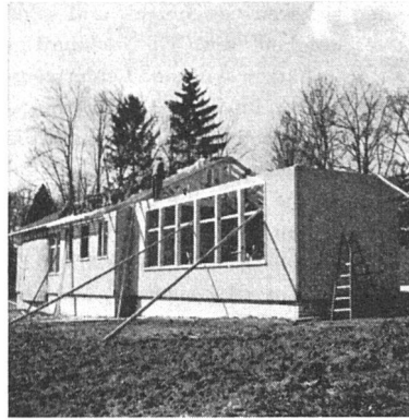
Der Pavillon im Bau (Montagebauweise)
