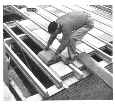
Fertigbalken-Decke (Ottiker Decke, Zürcher Ziegeleien, Ottiker K. A.G., Oberrieden) | Plancher à poutrelles préfabriquées | Precast floor-beams
