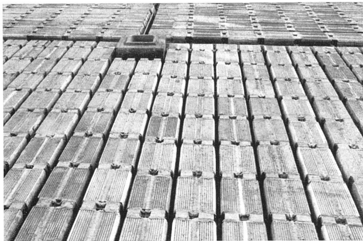
Stahlton-Decke mit vorgespannter Armierung (Zürcher Ziegeleien) | Hourdis avec armature précontrainte | Ceramic floor-units with pre-stressed reinforcing rods
