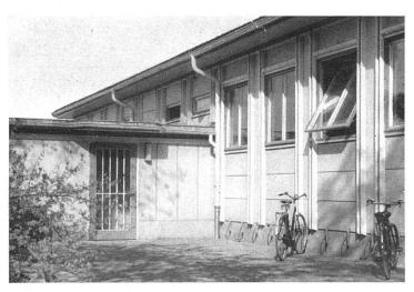
«Durisol»-Bauweise (Durisol AG. Dietikon), rechts gebräuchliches, links und unten neues System mit selbsttragenden Vertikalelementen (Vorschlag A. Roth, Arch. BSA) | Système «Durisol»; à droite le système actuel, à gauche et en bas nouveau système à éléments portants verticaux | «Durisol» construction, at right the present system, at left and below the new system with bearing vertical elements
