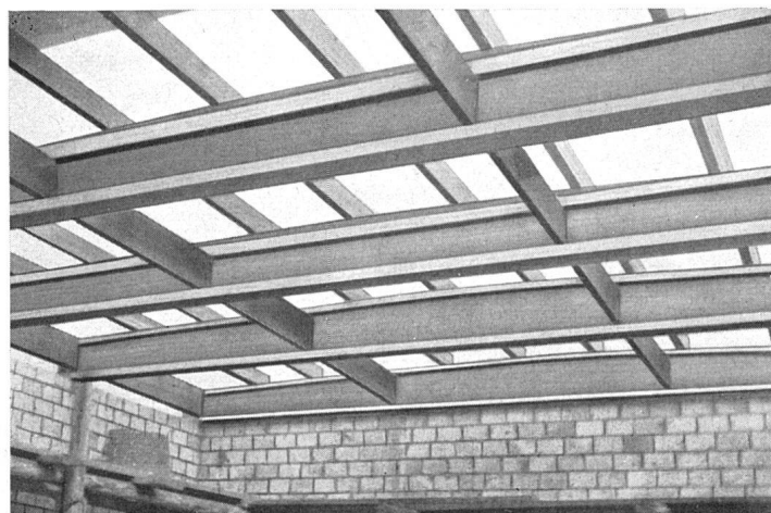
Geha-Holzträger (Spannweite bis 10 m) (E. & A. Meier, Zürich) | Poutrelles de bois collées, portées jusqu'à 10 m | Beams of bonded wood-sections, span up to 10 m
