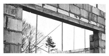
Vorfabrizierter Stahlton-Sturz (Zürcher Ziegeleien) | Poutrelle de fenêtre préfabriquée en terre cuite armée | Prefabricated window-beam of reinforced ceramic material
