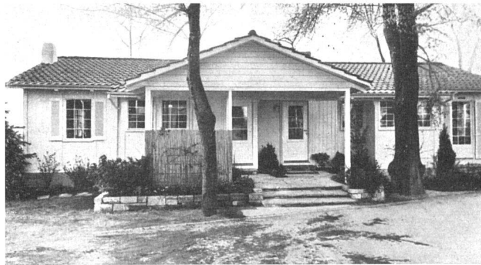
Oben und unten: Holzbauweise Gribi (Gribi & Co., AG., Burgdorf) Wohnhaus nach Entwurf von Lux Guyer, Architektin, Zürich / Mais en bois préfabriquée / Prefabricated house in wood
