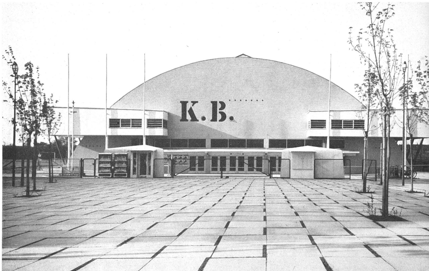
Haupteingang zum Hallenstadion mit Nordfront | Entrée principale du stade couvert | Main entrance of the covered stadium
