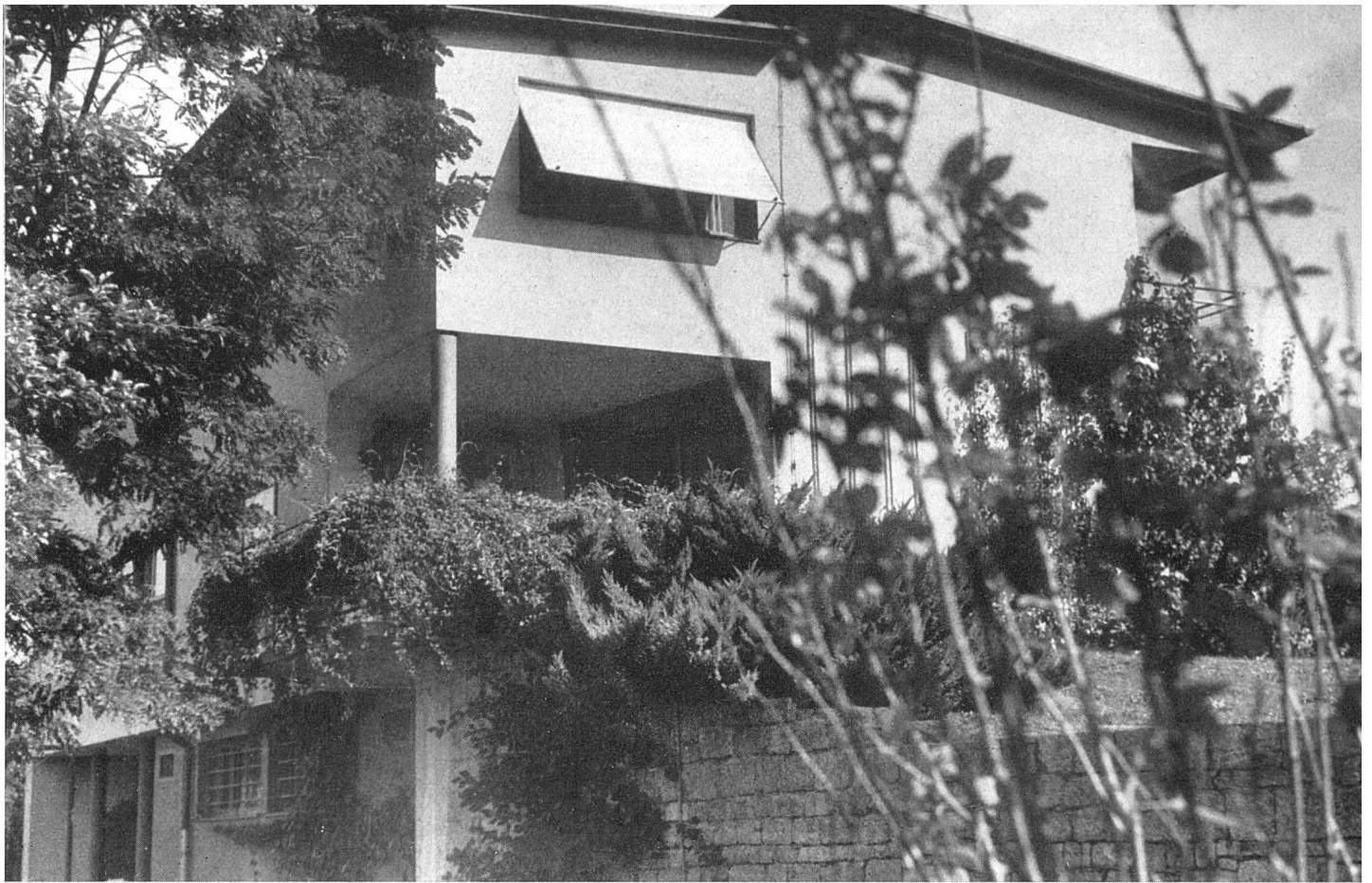
Ansicht von Nordwesten mit Terrasse und Kellerausgang | Façade nord-ouest, avec terrasse et accès au sous-sol | North-west elevation with and basement entrance
