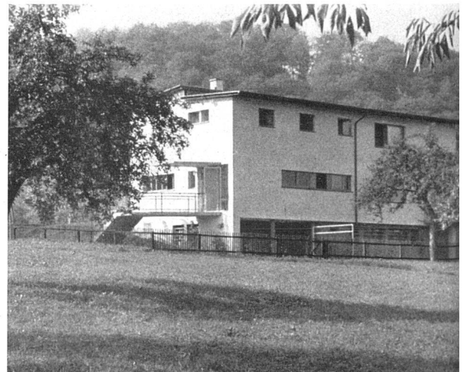
Ansicht von Osten | Façade est | View from the east
