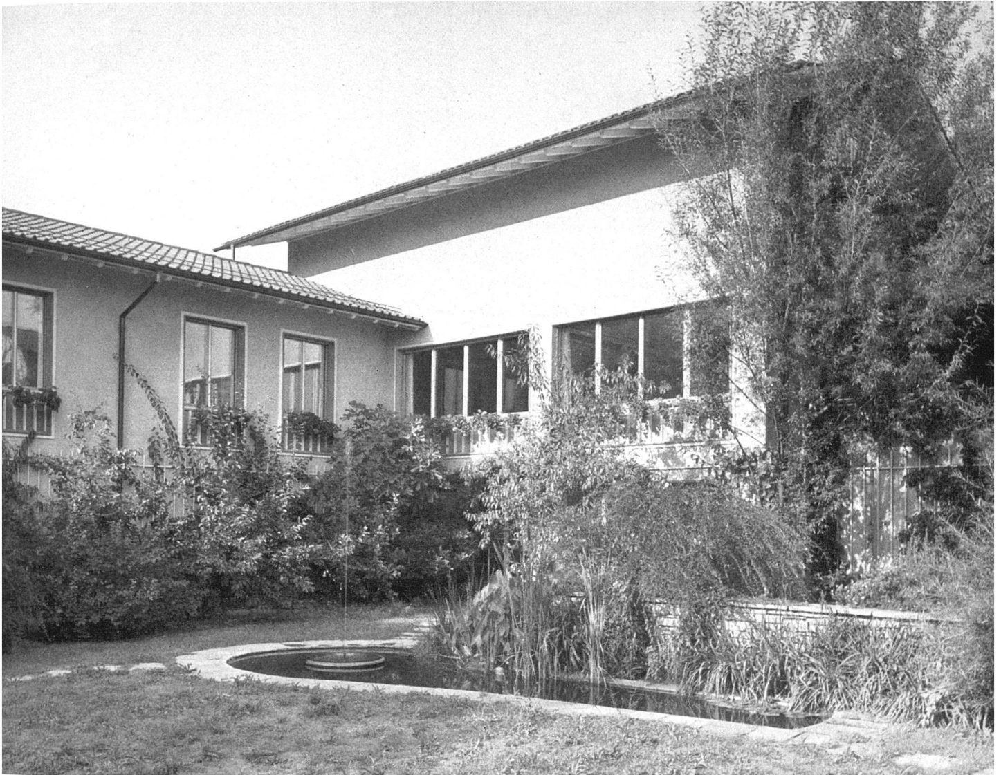
Wohnheim Prof. Dr. H. Hofmann, Architekt BSA, Zürich, Gartenhof mit Fischteich / Maison de l'architecte; coin du jardin avec vivier / The architect's house; living area of the garden with fish-pond Photo: M. Wolgensinger SWB, Zürich
