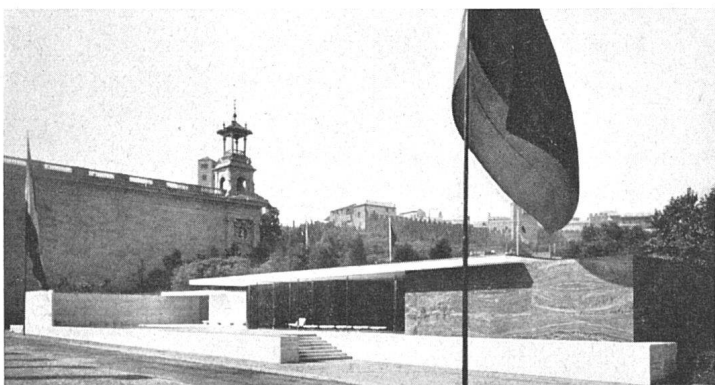
Barcelona 1929. Deutscher Pavillon ( Arch. Ludwig Mies van der Rohe ). Reine Architektur mit Konzentration auf harmonisches Zusammenwirken von Material, Form, Möbeln und freier Kunst | Architecture pure basée sur l'harmonie des formes, de matériaux, de meubles et des œuvres d'art | Purity of design deriving from the harmony of forms, materials, furniture and works of art
