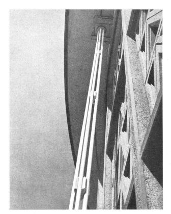
Principe constructif et architectu al moderne, béton armé et tirants extérieurs. Université de Fribourg, Dumas & Honegger, architectes | Aus der Konstruktion entwickelte Architektur der Gegenwart. Eisenbeton und sichtbare Zugstangen | Modern structural and architectural conception; ferro-concrete and visible spreaders
