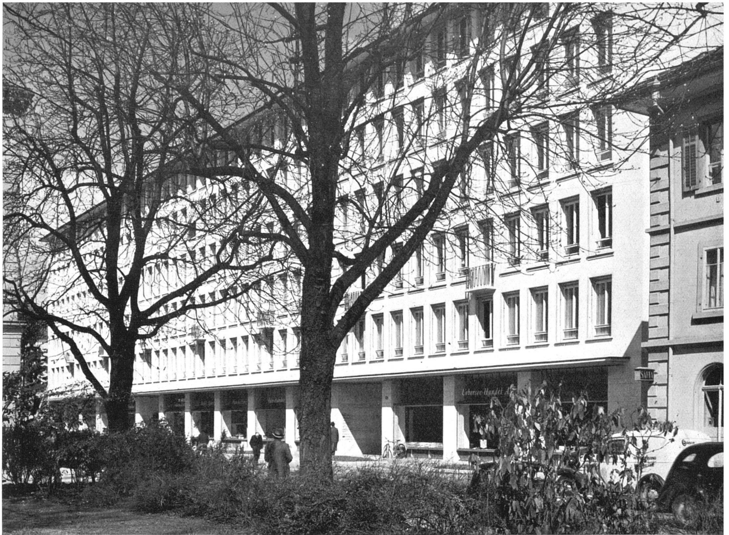
Hauptfront gegen Talstraße | La façade principale (sud-ouest) | Main elevation
