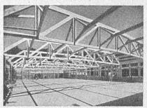
Vorfabrizierte Vorspannbeton-Konstruktion Vobag AG. Zürich
