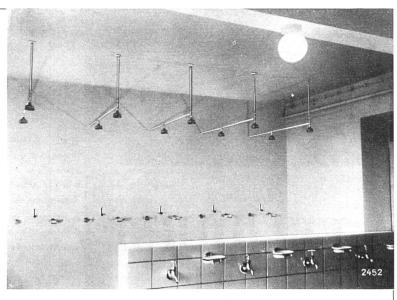
Duschenanlage mit getrenntem Apparateraum (total 20 Duschen, je 2 an einem Apparat)
