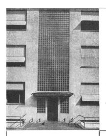
Treppenhauswand ausgeführt mit Glasbausteinen «Verlith/Vitrablock »
