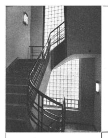
Treppenhauswand ausgeführt mit Glasbausteinen «Verlith/Vitrablock»
