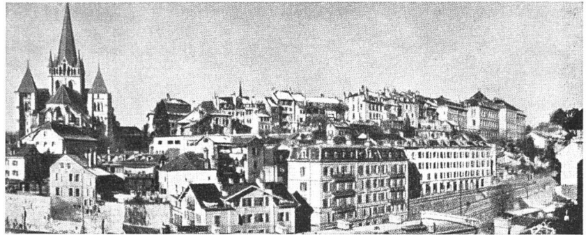
Die Lausanner Stadtkrone von Osten gesehen, mit den sanierungsbedürftigen Wohnbauten
