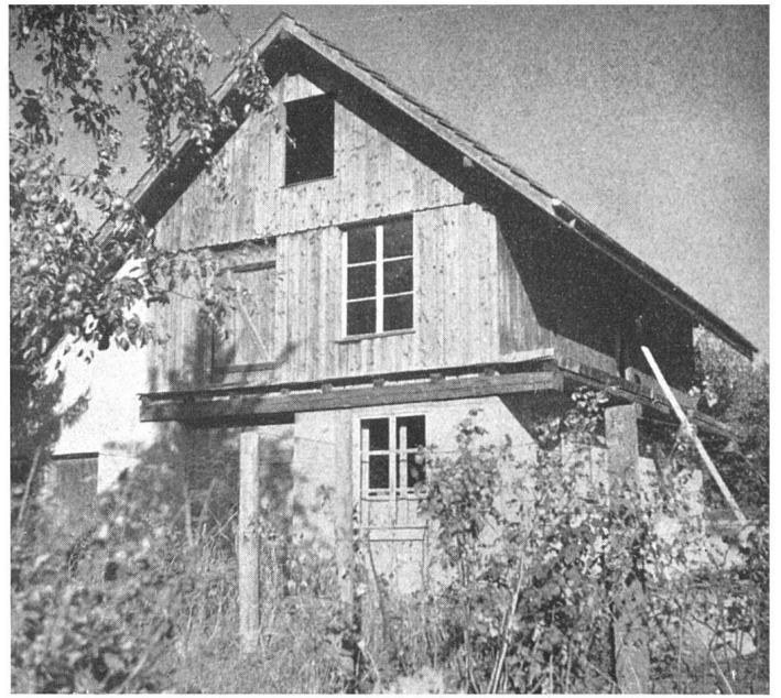
Die Scheune vor dem Umbau / La grange avant la transformation The barn before the remodelling
