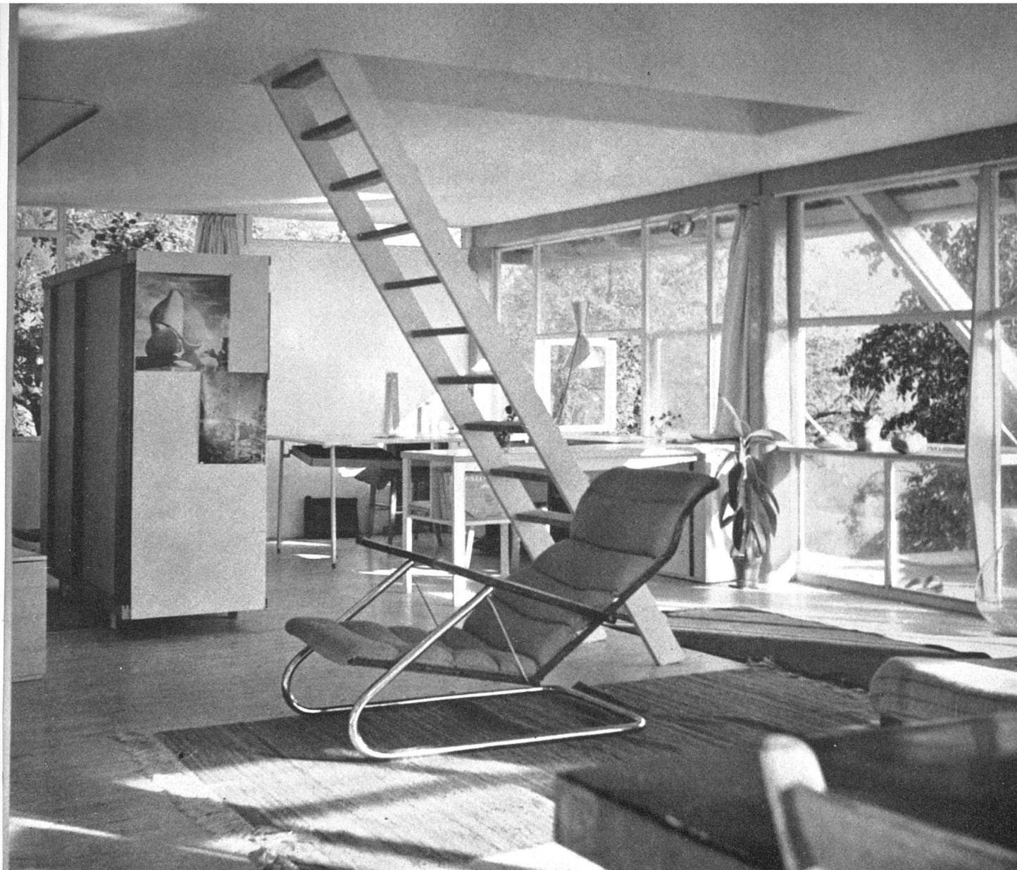
Blick vom Wohnteil in den Arbeitsteil. Die Fensterfront ist zum großen Teil fest verglast (doppelt). Treppe in den Dachraum wegnnehmbar | Coin de travail vu de la partie habitation. Fenêtres en majorité fixes (double vitrage) / The working space seen from the living area. Majority of window fixed, with double glazing
