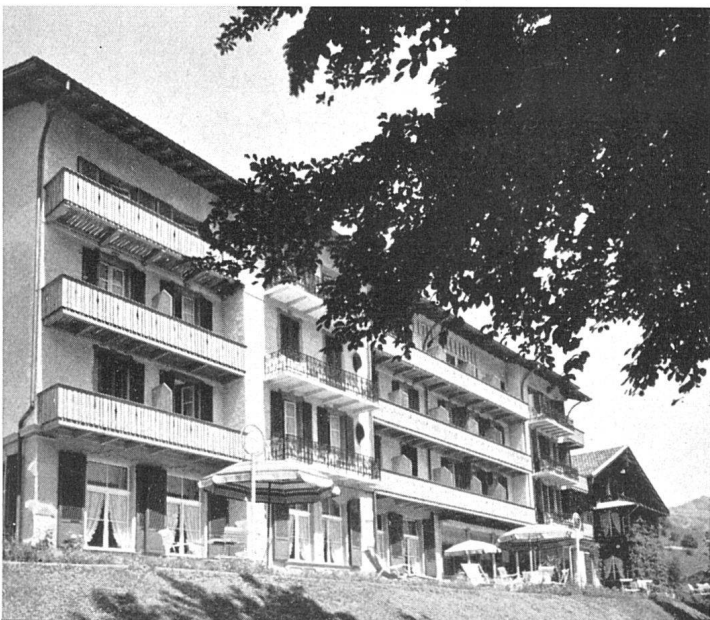
Südfront mit neuem 3. Geschoß und neuen Balkonen / Façade sud de l'hôtel, avec le nouveau 3ème étage / South elevation with new 3rd floor
