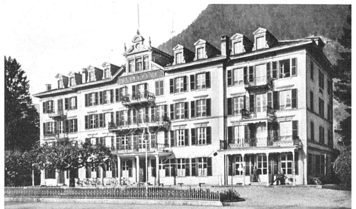
Das Hotel vor dem Umbau | L'hôtel avant la transformation | Before the remodelling
