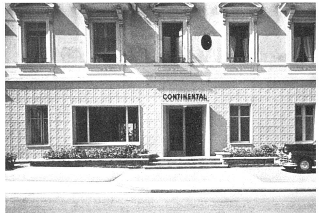
Umgebauter Hoteleingang, jedoch noch ohne projektierte Überdachung / L'entrée de l'hôtel après la transformation, mais sans l'avant-toit / Main entrance in its present state still without pent-house
