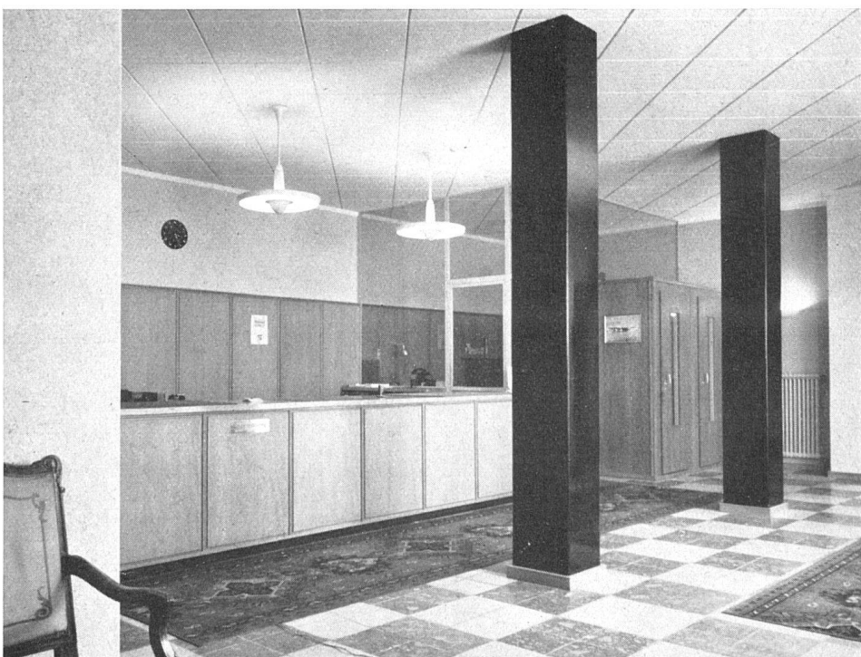
Empfangshalle, Boden aus alten Marmorplatten neu verlegt, Säulen vierfach gespachtelt und schwarz hochglanz poliert / Le hall de réception; piliers vernis en noir / Reception hall, pillars black polished
