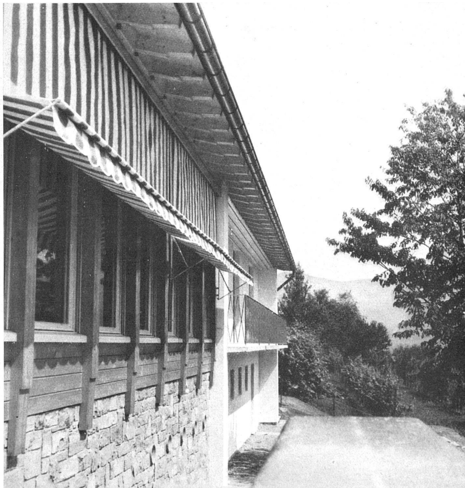
Wohnhaus in Sorengo, Fassadenausschnitt. Mauerwerk aus graublauem Calprino-Stein, weißer Putz, Holzwerk grün und Geländer rot gestrichen | Maison d'habitation à Sorengo, partie de la façade sud | House at Sorengo, part of south elevation
