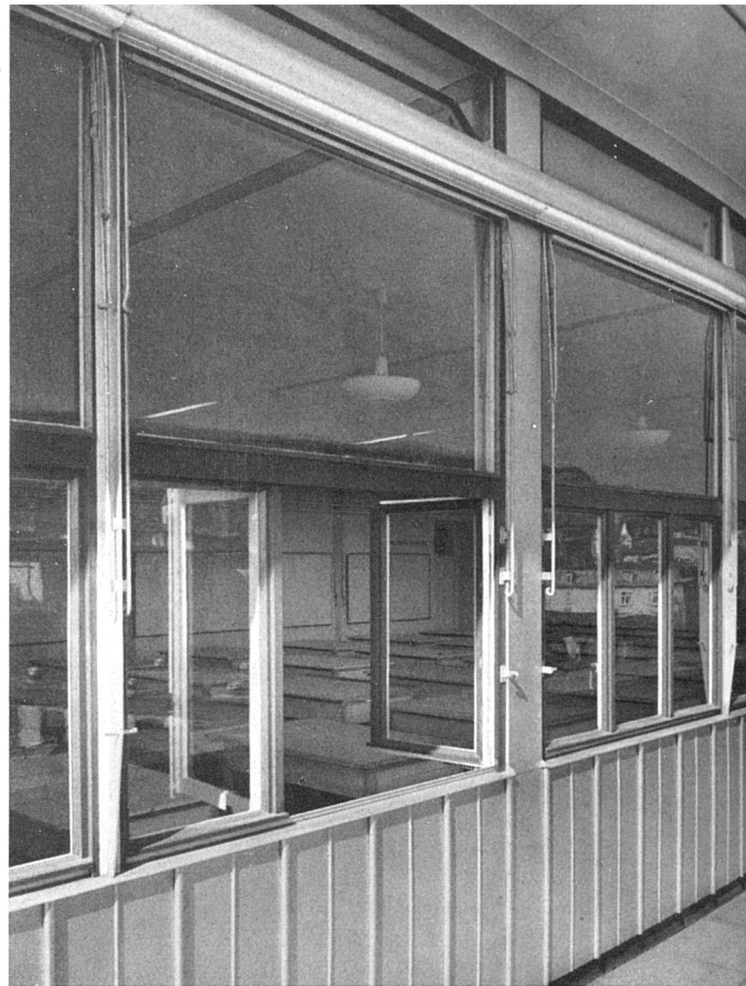
Ausschnitt Ostfront (Zeichensaal) / Détail de la façade est (aluminium anodisé) / Part of east elevation (drafting-room)
