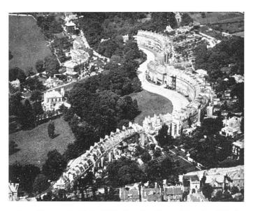
nsdowne Crescent in Bath 1794. Der Baukörper folgt den Geländeven / Le bâtiment suit les contours du terrain / The building follows contours of the site
