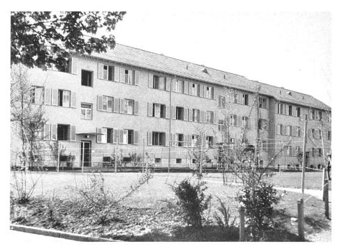
Wohnbauten in Zürich, ausgeführt im System Schindler/Göhner 1947. Bauzeit 3 Monate. Kos 10–15% billiger als bei normaler Bauweise | Ce système permet la construction à étages multip habitations bon marché à Zurich | A system for multistory houses, block of flats in Zur
