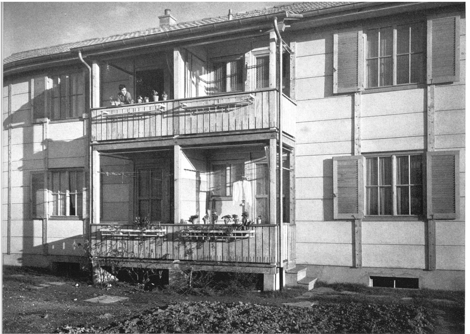
Gartenfront mit Wohnbalkon / Façade vers le jardin avec balcons de bois / Garden elevation with balconies in wood Photo R. Spreng SWB, Basel
