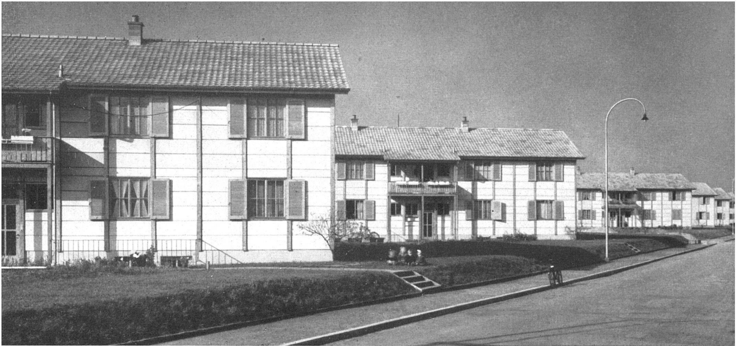
Gesamtansicht von der Neudorfstraße aus / Vue d'ensemble prise de la rue / General view from the street
