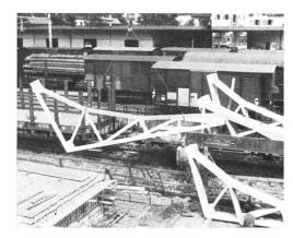
Transport der Binderhälften | Transport des élér Transport of the units
