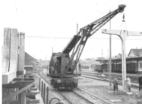
Transport und Montage der Elemente | Transport et montage des éléments | Transport and erection of the units
