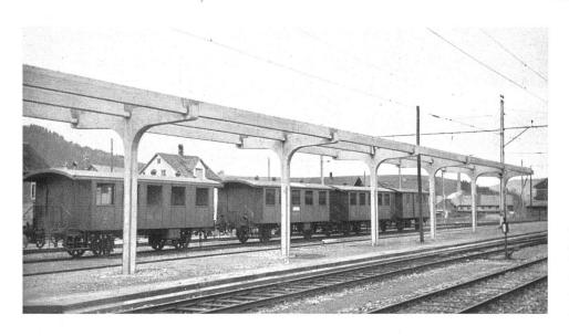
Perrondachanlage Einsiedeln. Die vorfabrizierten Stützen und Pfetten wurden innert 7 Tagen montiert | Toit de quai de gare, construit en éléments préfabriqués | Railway shelter built of prefabricated units
