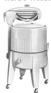
mit Kreuz und Auswindvorrichtung, elektrischem Antrieb, 220 Volt, weiß emailliert, mit Rollen versehen und eingebauter elektrischer Pumpe. Auch Sie werden entzückt sein vom Modell 1948. Ein wirklich praktischer Bedarfsartikel zu erschwinglichem Preis.
