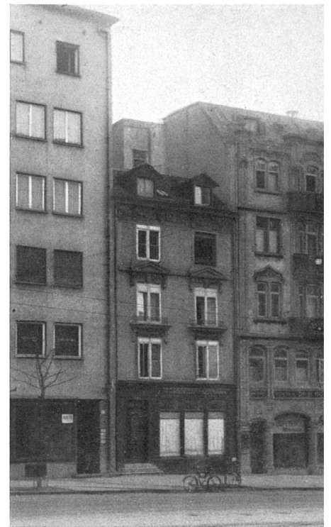
Zustand vor dem Umbau | L'état antérieur Before the remodelling
