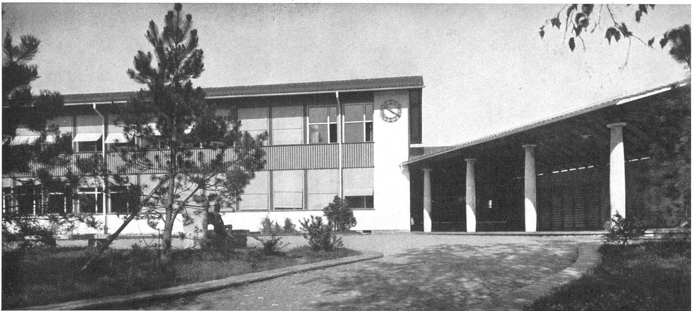
Gesamtansicht von Südosten / Vue d'ensemble, prise du sud-est / General view from the south-east
