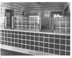
Schalteranlage in der Uhrenfabrik «Eterna», ausgeführt mit Glasbausteinen Verlith/Vitrablock Nr. 120, 20/20/5 cm
