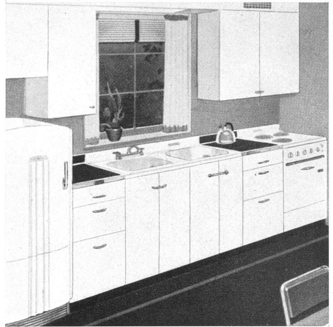
Abb. 3. Zusammenhängende Arbeitsflächen. Das Vorbereitungs- und Reinigungszentrum der elektrischen Küche, 1942 (General Electric Corp., Schenectady, N. Y.) / Surfaces continues de travail: centre de préparation et de nettoyage d'une cuisine électrique, 1942 / Continuous working surfaces: preparation and cleaning center of electric kitchen, 1942
