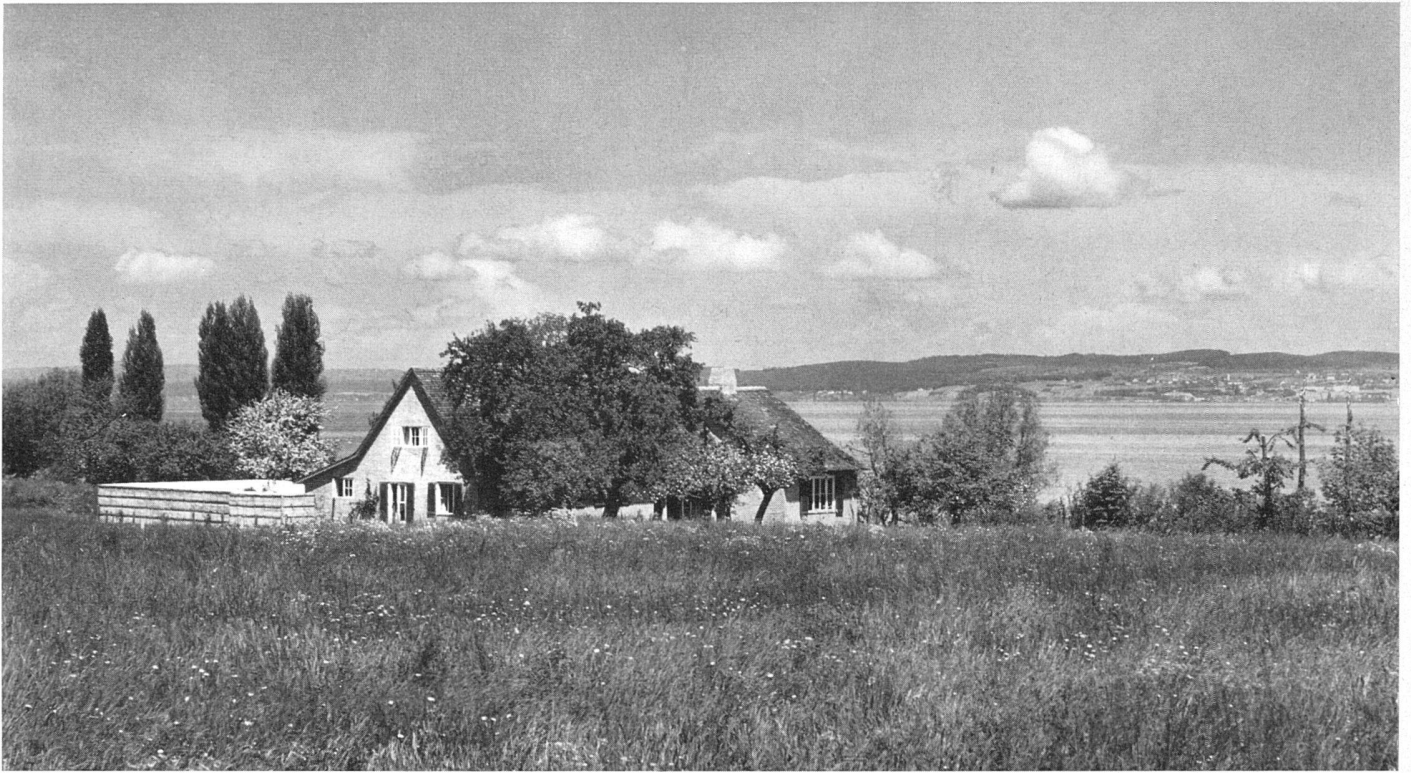
Gesamtansicht von Süden / Vue d'ensemble prise du sud / General view from the south
