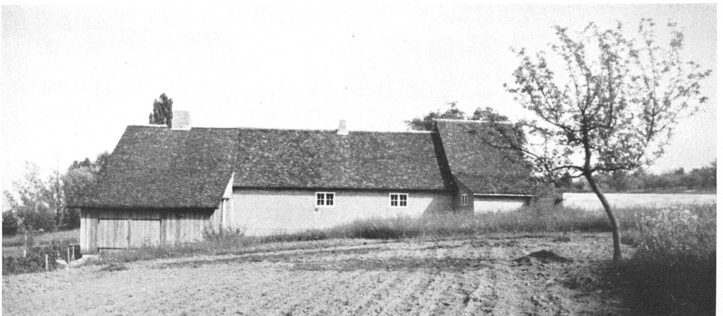
Ansicht von Westen, links Garage und Hauseingang / Vue prise de l'ouest, à gauche le garage / View from the west, left the garage
